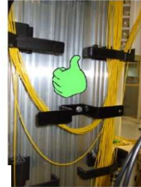
Enroulement direct autour d'un anneau
