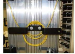
Enroulement direct autour d'un anneau
